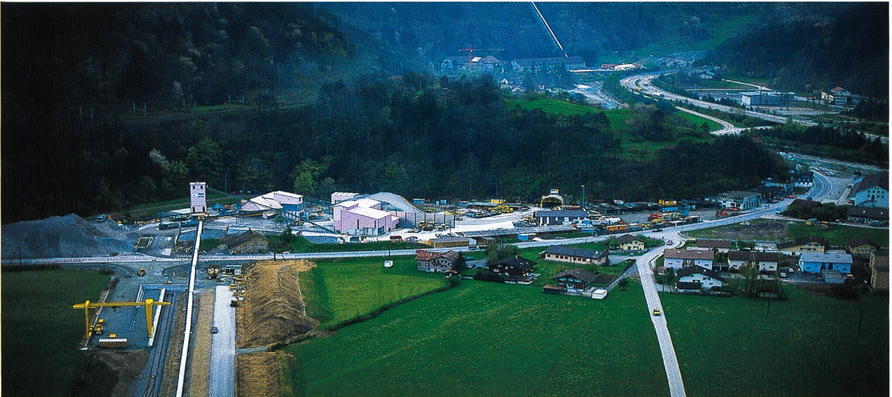
Bild 10. Die Baustellen im Bereich Grund von Norden aus gesehen. Links Verladeeinrichtung mit Baupiste, Kiesaufbereitungs- und Betonanlage. Zugang zum Unterwasserstollen in Bildmitte. Im Hintergrund rechts die alte Druckleitung und die Kraftwerkanlage (Foto Heinz Baumann, Altdorf).
