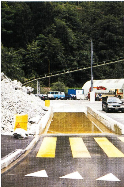
Bild 31. Im Brindli wurde eine Lastwagen-Waschanlage installiert.
