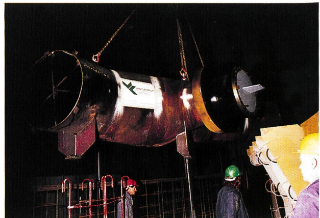
Bild 23. Teilstück der Ringleitung am Kranhaken.
