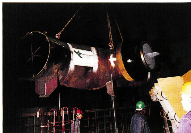
Bild 23. Teilstück der Ringleitung am Kranhaken.
