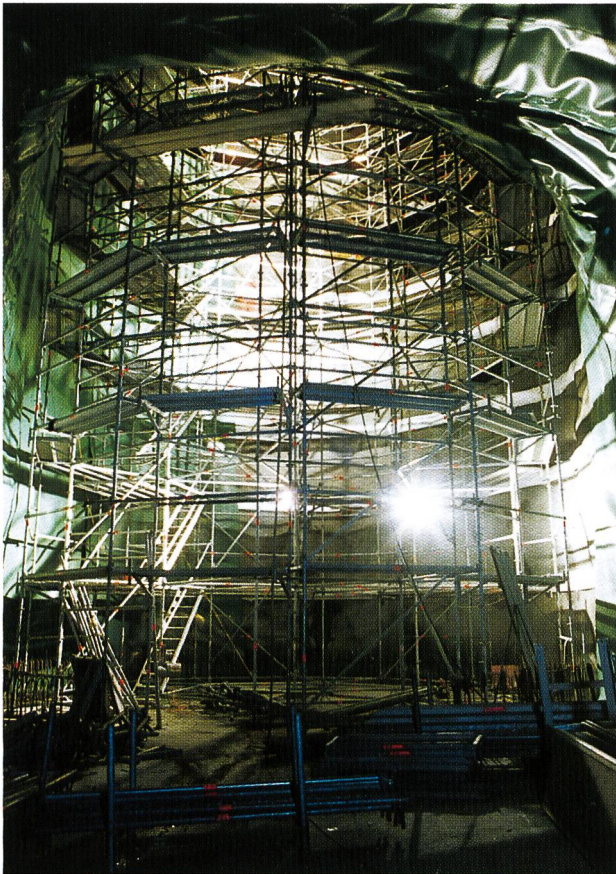
Bild 14. Gerüst für die Isolation des Wasserschlossdruckschachtes, der die untere mit der oberen Wasserschlosskammer verbindet. Der Schacht ist 25 m hoch und hat einen Ausbruchdurchmesser von 11 m (Foto P. Mainardi vom 3. Juni 1996).
