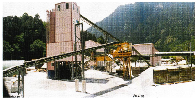
Bild 22. Zugunsten der Umwelt wurde das Ausbruchmaterial mit Förderbändern vom Brindli über die Kantonsstrasse zur Verladestation im Grund gebracht. Mit Blockzügen von 1000 t fuhr das Material auf dem Werkgleise nach Erstfeld und weiter. Mit diesem Werkgleise konnten die Lastwagentransporte minimiert werden (Foto P. Mainardi vom 24. Juni 1994).
