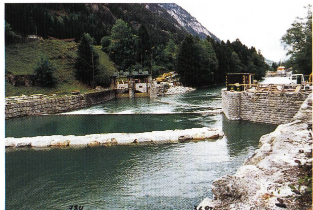
Bild 11. Das neue Einlaufbauwerk Pfaffensprung, rechts, mit Wehrschwellen zur Geschieberückhaltung.
