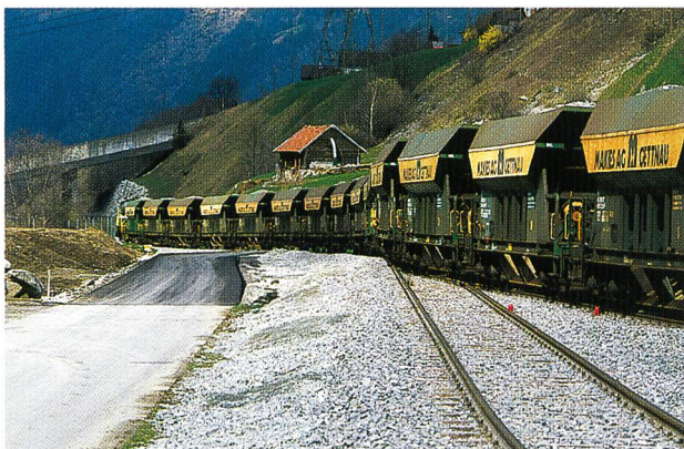
Bild 35. Über 1 Mio t Aushubmaterial wurde über ein eigens gebautes Werkgeleise von Amsteg nach Erstfeld und von dort weiter mit der Bahn abgeführt (Foto Heinz Baumann, Altdorf).
