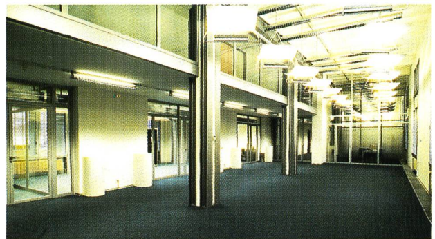
Bild 43. Umgebautes Betriebsgebäude: Kommandoraum und Rechenzentrum mit darüberliegender Klimazentrale (links oben).
