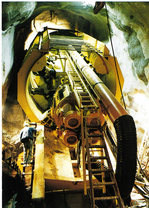
Bild 19. Montage der Startröhre für die Druckschachtfräse. Der Schacht ist 382 m lang und hat ein Gefälle von 85 %. Vom Fuss wurde der Schacht mit 3,8 m Durchmesser Richtung Wasserschlussskammer gefräst. Nachher wurde der Schacht in Gegenrichtung auf 4,2 m aufgeweitet (Foto P. Mainardi vom 23. August 1995).
