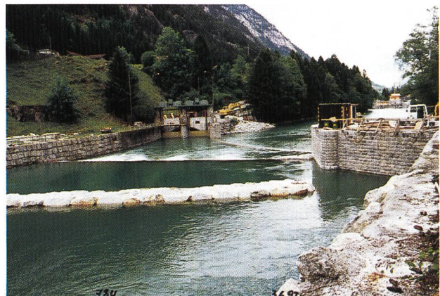
Bild 11. Das neue Einlaufbauwerk Pfaffensprung, rechts, mit Wehrschwelle zur Geschieberückhaltung.
