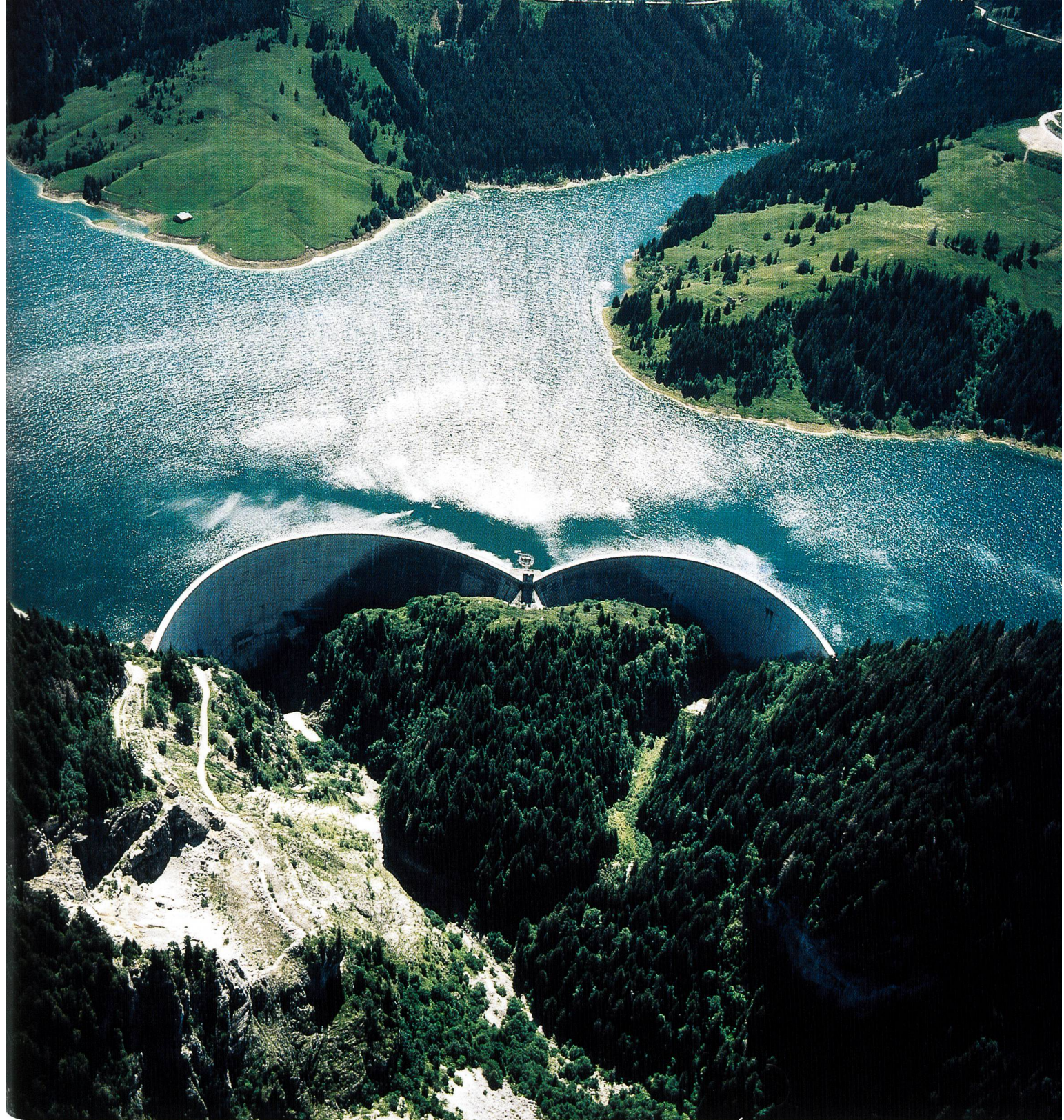
Figure 1. Vue aérienne du barrage-voûte double de l'Hongrin. Bild 1. Flugbild der Zwillingssbogenmauer Hongrin.
