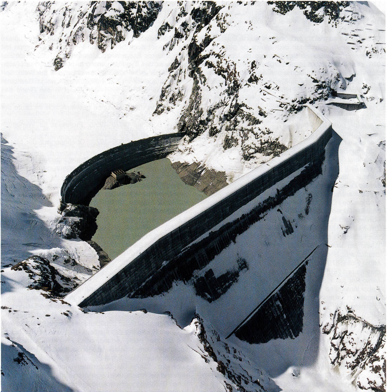
Figure 2. Le barrage-poids de la Grande Dixence, construit de 1951 à 1961. A retenue vide on aperçoit l'ancien barrage à contreforts de la Dixence (Photo: H. Preisig 1996).
