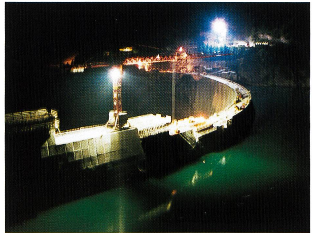
Figures 7 et 8. Surélévation du barrage-voûte de Luzzzone (construit de 1958 à 1963) dans les années 1995/1997.
