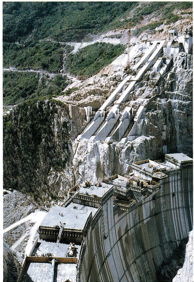
Figure 13. Barrage-voûte de El Cajon en Honduras, construit de 1979 à 1985 (Projet Motor-Columbus Ingénieurs Conseils SA).
