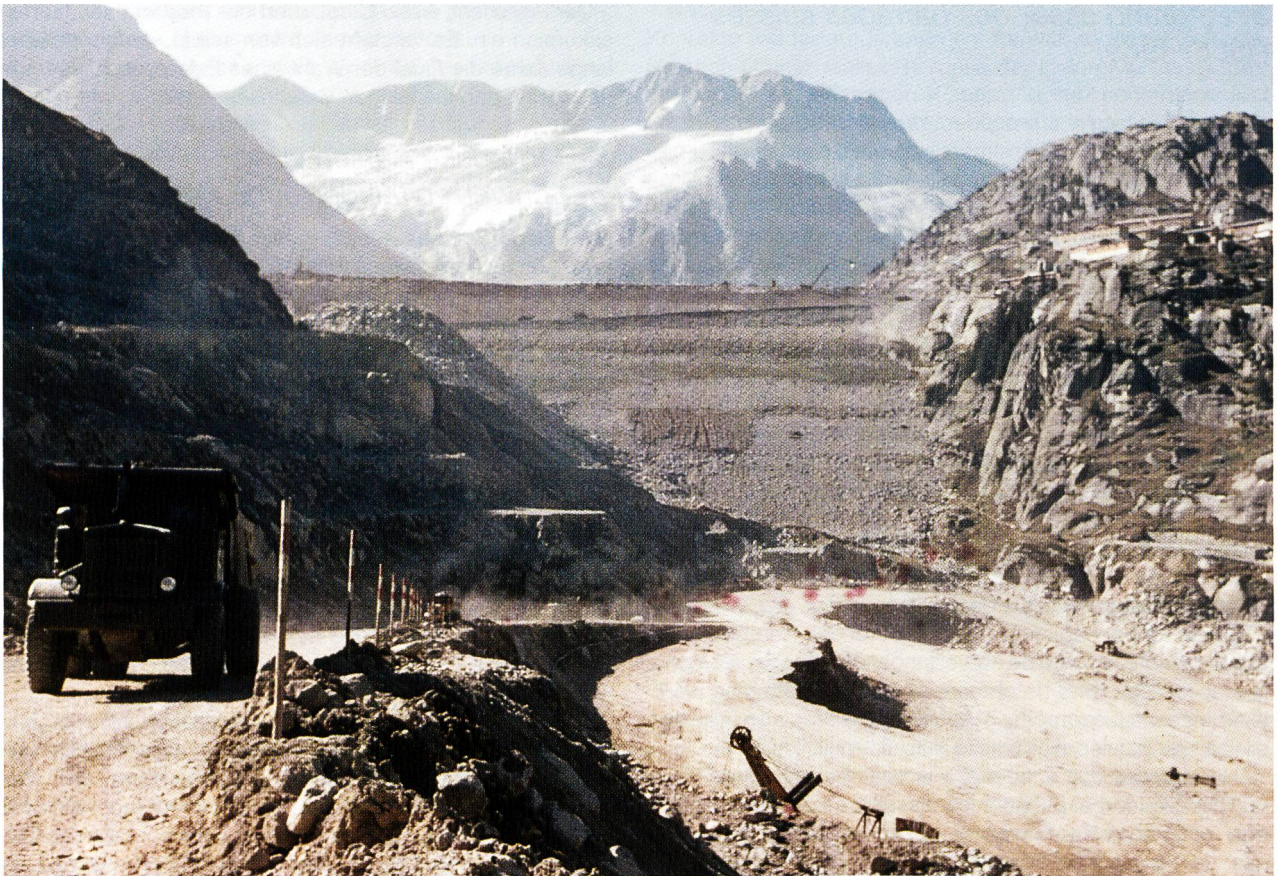
Figure 4. La digue de Göscheneralp de la Kraftwerk Göschenen AG vers la fin de la construction (1956 à 1960).
