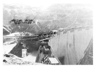
Bild 2. Radialfahrbare Kabelkräne beim Staumauerbau (Krupp/PWH)
