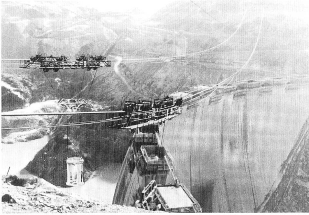
Bild 2. Radialfahrbare Kabelkräne beim Staumauerbau (Krupp/PWH).
