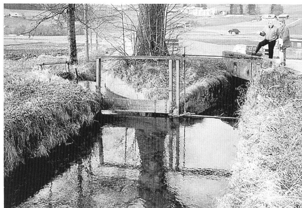
Bild 2. Das Wehr in Fließrichtung gesehen. Rechts der Biglenbach, links der Enggsteinbach (Foto: Tiefbauamt BE).
