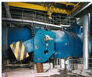
Aménagement Cleuson-Dixence Le Chargeur: vue sur la vanne papillon de sécurité. Wasserkraftanlage Cleuson- Dixence. Le Chargeur: Drosselklappe (Foto H. Preisig, CH-1950 Sion le 4 mai 1998).
