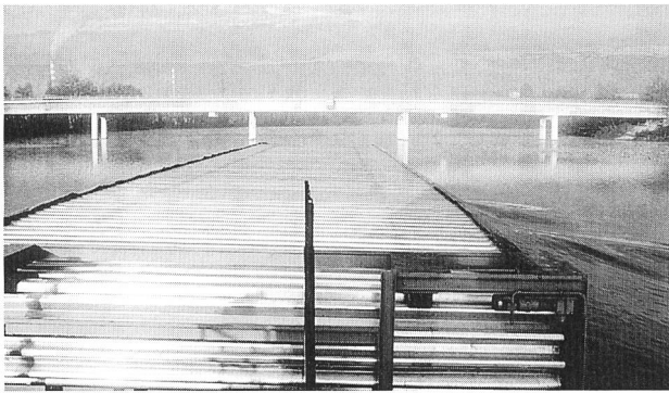
Figure 5. Encore quelques centaines de mètres et la barge pleine sera arrivée aux Cheneviers. Le point le plus délicat du parcours, en cas de fort vent latéral, est le pont de Peney, illuminé ici par un rayon de soleil et vu depuis l'amont. Les barges sont fermées par des rideaux pendant le transport, ceci pour éviter la dissémination des odeurs et l'arrivée de trop nombreux oiseaux cherchant de la nourriture. Le tirant d'air sous le pont est de 9,0 m et la largeur entre deux piles de 38,5 m.
