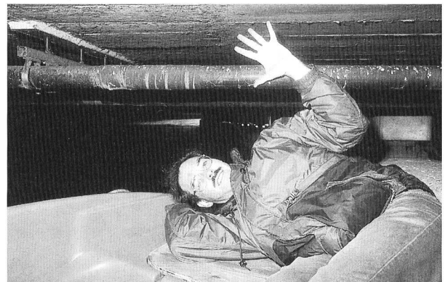
Figure 11. Lors de l'inspection du 9 octobre 1998, effectuée pour la mesure des tirants d'air en vue de la révision de [4], l'auteur couché montre avec ses doigts écartés (empan = 24,5 cm) la hauteur perdue avec les conduites de télécommunications dont 0,15 m sont déjà perdus en hauteur à cause de la suspension pas optimale. La hauteur globale «perdue» pour la navigation est de 0,30 m. Avec un tirant d'air de 1,10 m le passage sous le pont de l'île est possible en inclinant la tête.
