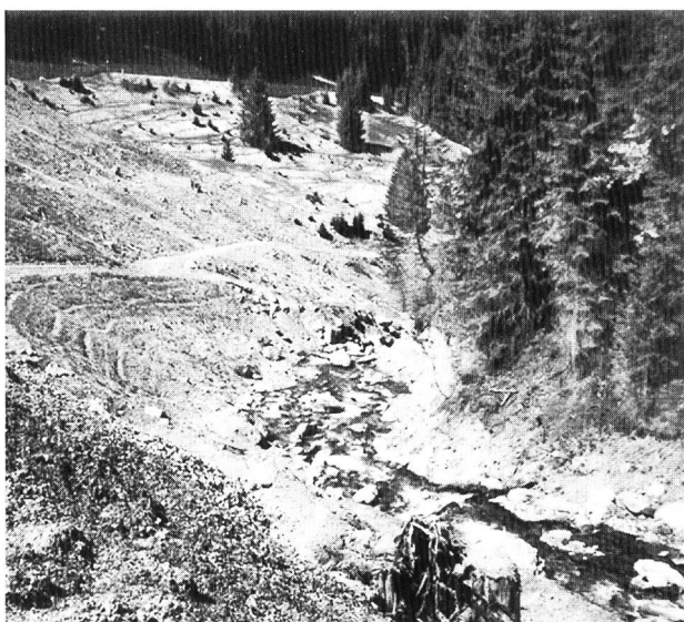
Bild 5 (Mai 1997). Blick in den grosszügig angelegten Mittellauf im geschütteten Gerinneabschnitt. Links die der natürlichen Begrünung überlassene Schützböschung «Bim Bad».
