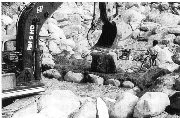
Bild 4 (August 1995). Gerinnesicherungsarbeiten im Schützbereich, hier am Fusse der Steilstrecke. Das verwendete Schüttmaterial bestand aus gefrästem Vereina-Tunnelausbruch und wies ein Maximalkorn von lediglich etwa 15 mm auf.
