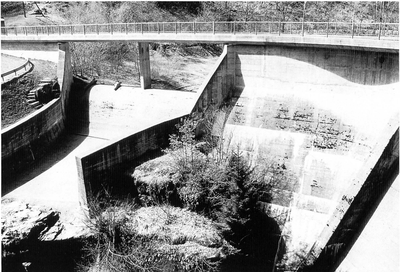
Bild 1. Die erhöhte Staumauer Molina im Calancatal.
