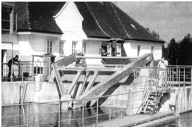
Bilder 1 und 2. Die Rechenreinigungsanlage des Amperkraftwerks Haag (Foto Muhr).
