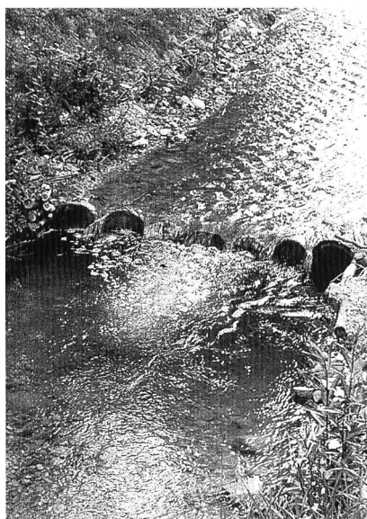
Bild 6, links. Holzschwelle Typ HR. Bild 7, Mitte. Situationsskizze für breitere Gerinne und die beiden Holzschwellen Typ HV und Typ HR. Bild 8, rechts. Abschnitt des Mederbaches in Marthalen, in dem die drei vorgestellten Absturztypen HV, HY und HR zur Anwendung kamen.
