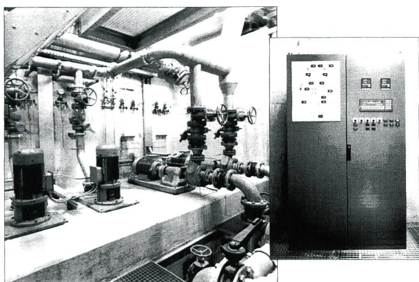
Bilder: Kühlwasseranlage mit kompletter SPS-Steuerung für den Neubau Wasserkraftwerk Wynau.
