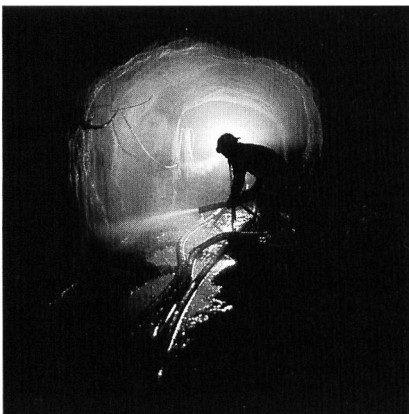
Bild 1. Erfahrene Spezialisten spritzen den qualitativ hochwertigen, dünnflüssigen Beton auf die lockeren Felsabschnitte. Die so aufgetragenen Schichten weisen je nach Bedarf eine Stärke von bis zu 20 cm auf.
