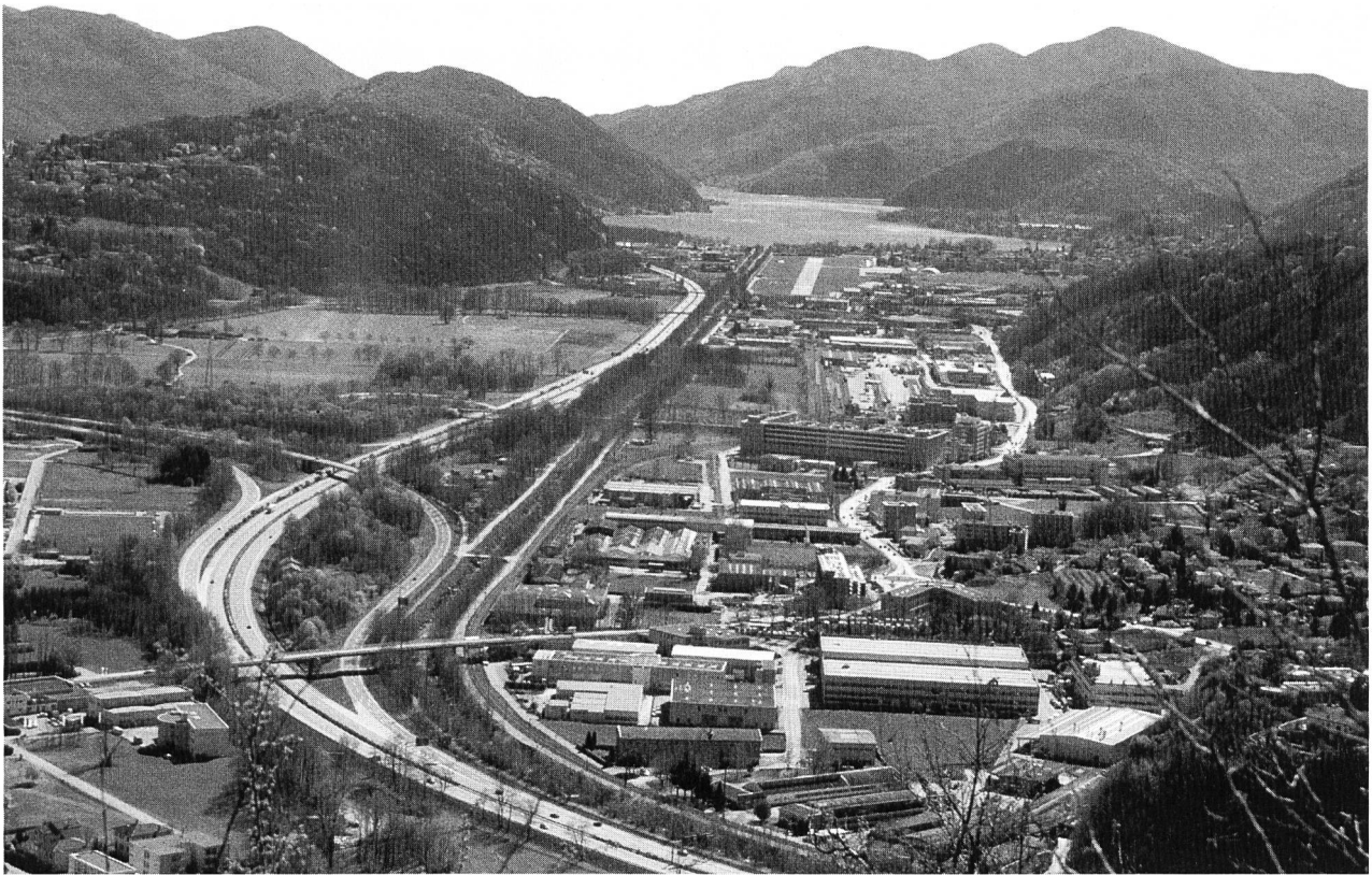
Figura 3. Il Vedeggio sulla Piana d'Agno, vista da San Zeno verso sud. La capacità attuale del canale, realizzato con la bonifica di inizio secolo, è insufficiente e pari in singole sezioni al 70% della portata di dimensionamento. Gli interventi previsti nell'ambito del progetto consistono in un allargamento della sezione e nella sistemazione degli argini. A monte del cavalcavia di Manno la creazione di una zona di espansione in sponda sinistra permetterà di migliorare l'aspetto ambientale.
