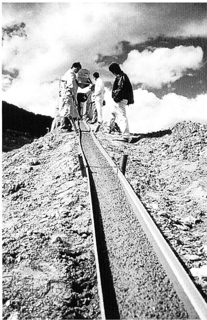
Figure 5. Principe de mise en œuvre des bétons fluidifiés, essais préliminaires.
