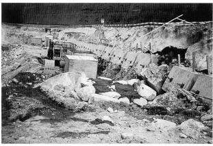
Bild 21. Erstellung der Betonprismen im Schutze einer verankerten Elementwand; im Vordergrund mit Residualblock verkabelte Blöcke (Gurtnellen–Güetli).
