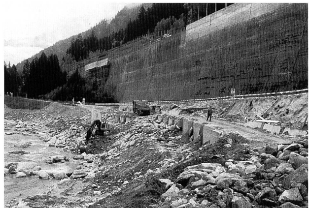
Bild 22. Betonprismen während der Überschüttung (Gurtellen-Gütli).
