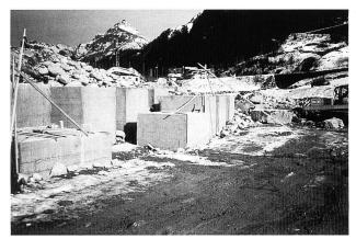
Bild 4. Diagonal getrennte Betonwürfel kurz vor Überschüttung (Gurtnellen-Wiler).
