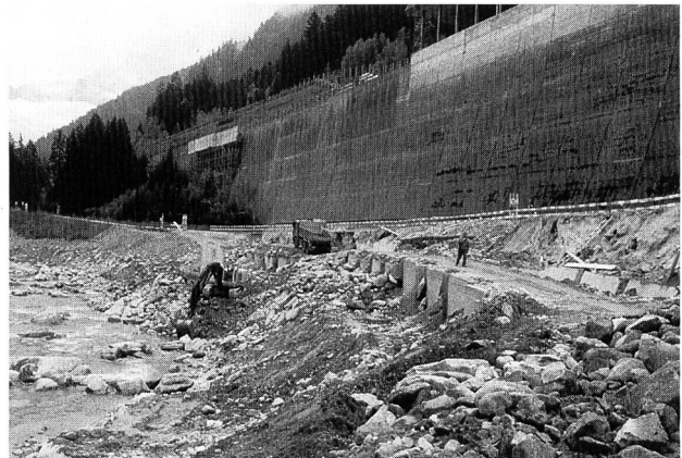
Bild 22. Betonprismen während der Überschüttung (Gurtellen-Güetli).
