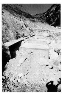
Bild 16. Im Wuhrweg eingegrabene Betonwürfel (Göschenen-Stäfeligand).
