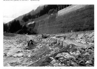
Bild 22. Betonprismen während der Überschüttung (Gurtnellen-Güetli).
