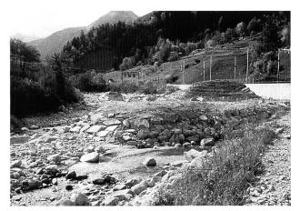
Bild 5. Halbinsel kurz nach Beendigung der Bauarbeiten, im Hintergrund künstlicher Umlenksporn (Gurtnellen-Wiler).
