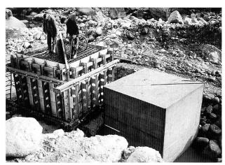
Bild 2. Diagonal getrennte, geschalte und leicht armierte Betonwürfel (Gurtnellen-Wiler).
