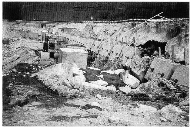
Bild 21. Erstellung der Betonprismen im Schutze einer verankerten Elementwand; im Vordergrund mit Residualblock verkabelte Blöcke (Gurtellen-Güetli).
