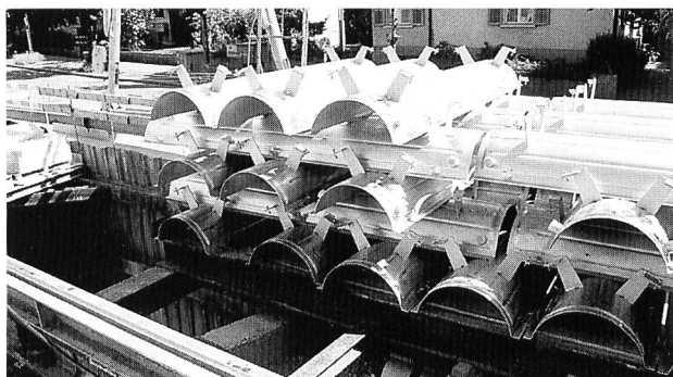
Bild 2. Die neuentwickelten Rabtherm-Wärmetauscher liegen zum Einbau in die Kanalisation bereit (IBA Stadt Zürich).
