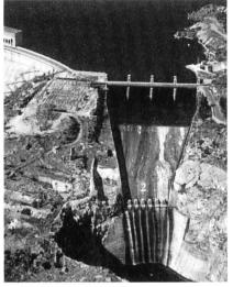
Bild 1, links. Almendra 1970. Die Bogensperre ist 202 m hoch und zusammen mit den Anschlussbauwerken 567 m lang. Vom grossen Stausee führt ein 15 km langer Druckstollen zu den Pumpen-Turbinen im unterirdischen Kraftwerk Villaring am Duero
