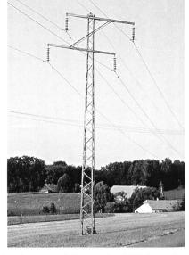
Figure 1. Pour la construction de nouvelles lignes de transport les CFF essayent, dans la mesure du possible, d'utiliser un tracé commun avec les lignes du réseau triphasé général ou un tracé longeant les voies ferrées. Notre vue montre un mat de la ligne commune Galmiz–Romanel–Verbois avec deux ternes à 220 kV (ultérieurement à 380 kV) de l'EOS et un lacet à 132 kV des CFF. Les deux isolateurs les plus élevés supportent les deux conducteurs des CFF.
