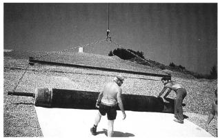
Bild 2. Ausrollen der Dichtungsmatte.
