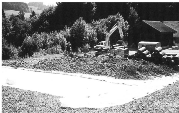
Bild 3. Schüttung der Rekultivierungsschicht.
