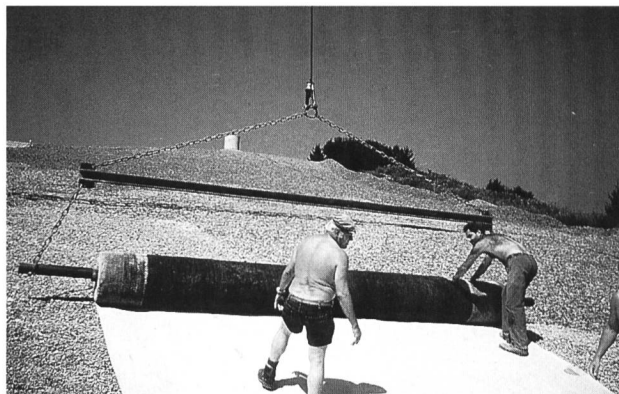
Bild 2. Ausrollen der Dichtungsmatte.
