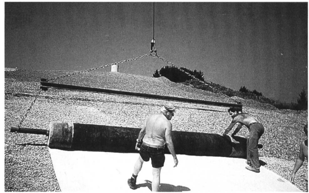
Bild 2. Ausrollen der Dichtungsmatte.
