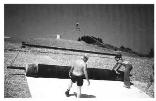
Bild 2. Ausrollen der Dichtungsmatte.
