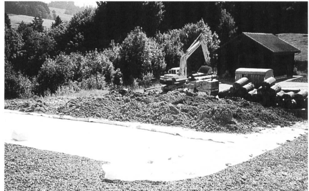
Bild 3. Schüttung der Rekultivierungsschicht.
