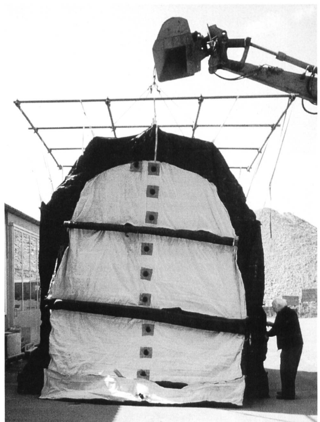
Bild 5. Pontoneinrichtung für die Unterwasserarbeiten.
