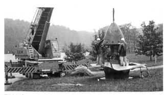
Bild 1. Generalrevision beim Wasserkraftwerk Bannwil 1997–2000. Das ausgediente Kaplan-Turbinenrad wiegt 22 t; sein Durchmesser beträgt 4200 mm.
