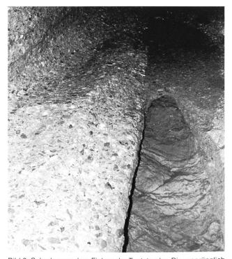
Bild 3. Schaden vor dem Einbau der Teststrecke. Die ursprünglich 40 cm starke Sohle ist vollständig abradiert. Darunter hat sich im anstehenden Fels ein tiefer Kolk gebildet.
