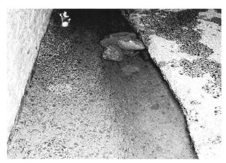
Bild 5. Aus der ungenügend verdichteten Randzone des Walzbetonfelds wurde eine 30 cm tiefe Rinne abradiert. Der genügend verdichtete Mittelteil des Feldes (rechts im Bild) weist keine nenneswerten Schäden auf.
