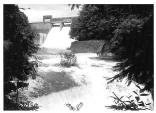
Überlauf an der Staumauer in den Schlagen (SZ, Etzelwerk). Die 1932 bis 1937 gebaute Gewichtsmauer staut den Sihlsee auf; sie schützt das Sihltal und die Stadt Zürich vor Hochwasser.
