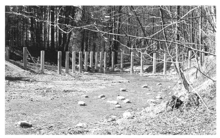
Bild 3. V-förmiger Treibholzfang, gebaut im Winter 1996/97: Aufgenommen kurz nachdem die Bauarbeiten beendet worden waren.
