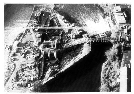
Bild 1. Erstellung des Krafthauses mit einem Wehrfeld (Bauzustand).
