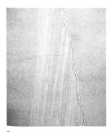
Bild 1. Radial- und Längsrisse infolge Schwindens in einer Betonauskleidung.
