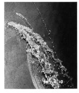
Bild 2. Lokale Wassereintritte durch die Risse einer Betonauskleidung während der Stollenentleerung (Bild EKW).
