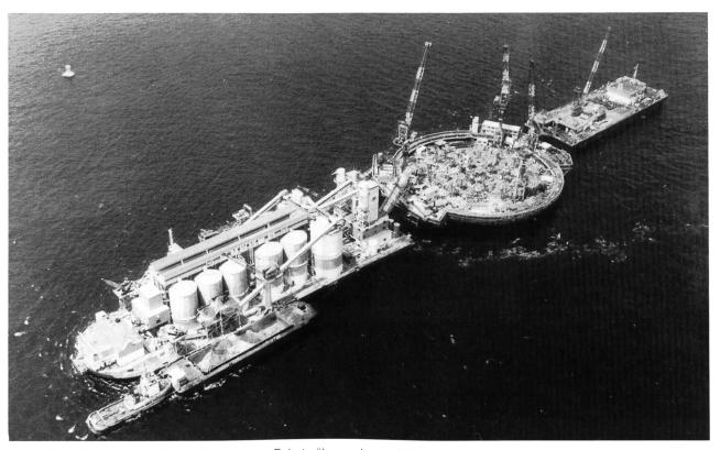
Bild 4. Caisson mit Arbeitsplattform (Betonpumpe, Roboterüberwachungseinrichtungen) und schwimmende Betonfabrik (links).
