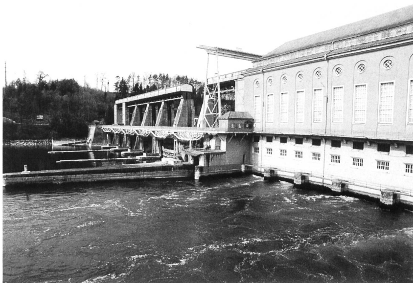
Bild 1. Kraftwerk Eglisau. Maschinenhaus und Stauwehr vom Unterwasser aus. 1993 bis 2000 Sanierung der Wehrpfeiler und Windwerkbrücke des Stauwehrs. Konzessionsprojekt 1997: Totalrevision der sieben Maschinengruppen bei gleichzeitiger Erhöhung des Wirkungsgrades und der Ausbaumassmenge; dies ermöglicht eine Produktionssteigerung um rund 22 %.
