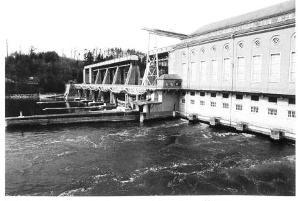
Bild 1. Kraftwerk Eglisau. Maschinenhaus und Stauwehr vom Unterwasser aus. 1993 bis 2000 Sanierung der Wehrpfeiler und Windwerkbrücke des Stauwehrs. Konzessionsprojekt 1997: Totalrevision der sieben Maschinengruppen bei gleichzeitiger Erhöhung des Wirkungsgrades und der Ausbauwassermenge; dies ermöglicht eine Produktionssteigerung um rund 22 %.
