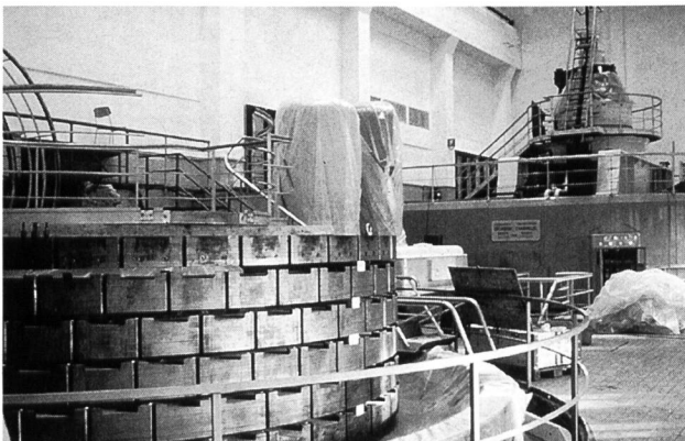
Bild 7. Hier steht das Fundament der Maschinengruppe 3, wo das Feuer ausbrach, für den neuen Stator bereit. Auch die Montage des neuen, «massgeschneiderten» Generators beansprucht mehrere Monate Zeit.
