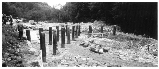
Bild 9. Treibholzfang im Lainbach (Südbayern, D) kurz vor der Fertigstellung. Die Blickrichtung ist flussabwärts. Das Einzugsgebiet bei der Sperrstelle beträgt 19 km² und der Dimensionierungsabfluss 200 m³/s (Foto des Autors).
