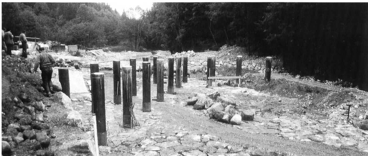
Bild 9. Treibholzfang im Lainbach (Südbayern, D) kurz vor der Fertigstellung. Die Blickrichtung ist flussabwärts. Das Einzugsgebiet bei der Sperrstelle beträgt 19 km^2 und der Dimensionierungsabfluss 200 m^3/s (Foto des Autors).
