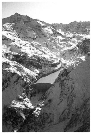
Bild 1. Die 1989 bis 1991 um 15,5 m erhöhte Bogenstaumauer Mauvoisin (Wallis) ist 250 m hoch. Der Stausee fasst 211 Mio m³ Wasser, das in den beiden Stufen Fionnay und Riddes genutzt wird.
