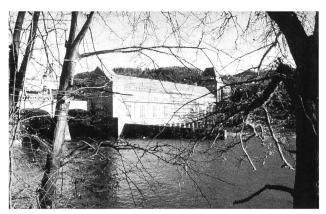
Bild 4. Das Rheinkraftwerk Laufenburg wurde nach Neukonzessionierung 1988 bis 1994 gründlich erneuert und ausgebaut.
