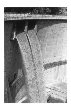
Bild 1. links. Bei der Staumauer Albigna des Elektrizitätswerkes der Stadt Zürich im Bergell werden gemäss Konzessionsvorschrift die Hochwasserspitzen auf 11 m³/s gedämpft.
