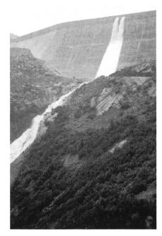
Bild 2, rechts. Hochwasserüberfall über die 67 m hohe Bogenstaumauer Ferden
