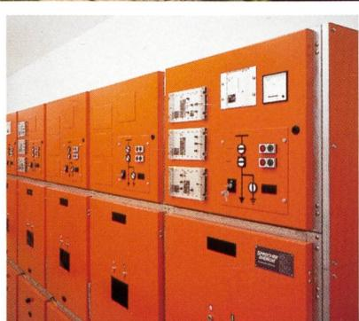
Die typengeprüften und metallgeschotteten Leistungsschaltanlagen PID 100 sind störlichtbogensicher und bieten daher grösstmögliche Personen- und Betriebssicherheit.
