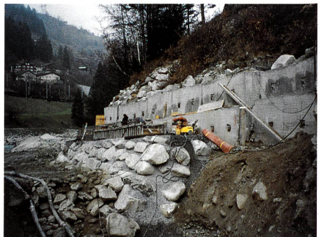
Bild 11. Gewichts-/Winkelstützmauer nördlich des Steintals.
