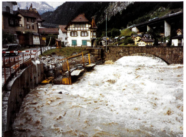
Bild 12. Hochwasserabfluss vom Juni 1992.
