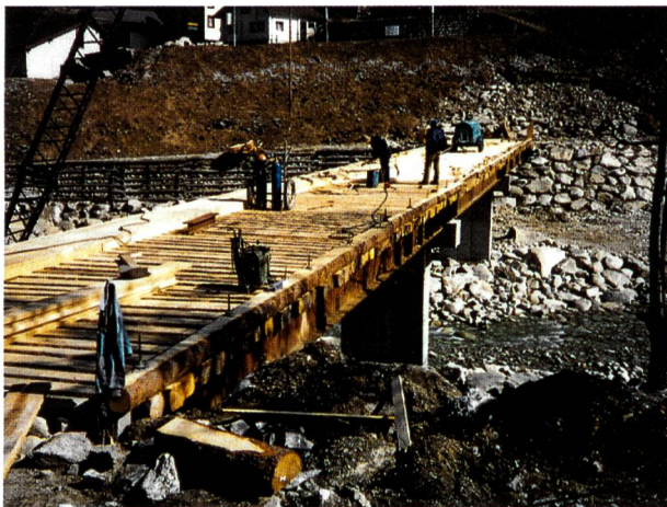
Bild 2. Erstellung der Baubrücke südlich Kirche.
