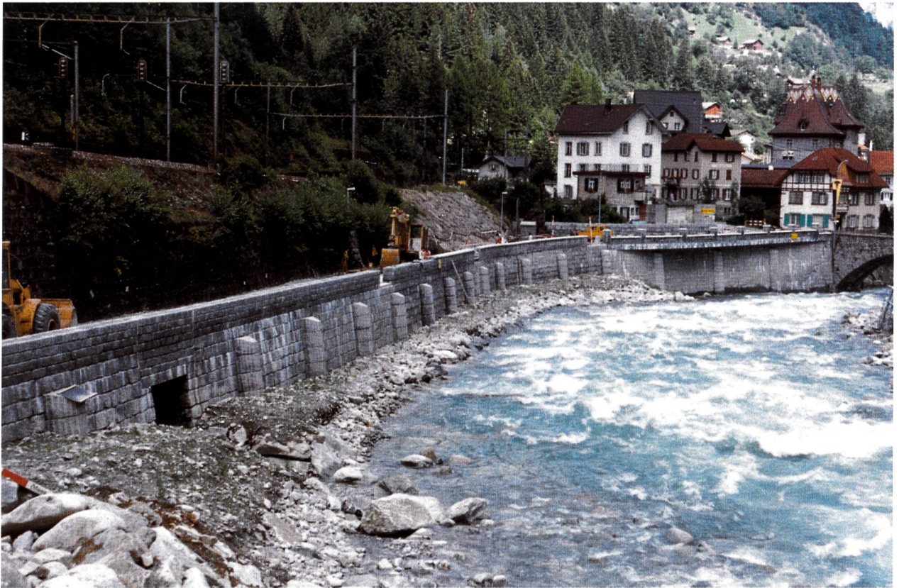
Bild 8. Hauptschutzelement C: Bruchsteinverkleidete Ufermauer oberhalb der Wilerbrücke.
