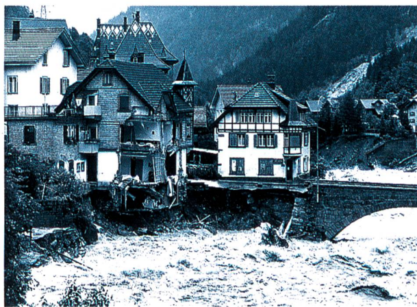
Bild 3. Zerstörte Kantonsstrasse südlich der Wilerbrücke (Comet Photo AG, Zürich).
