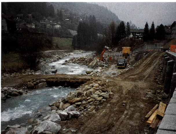
Bild 10. Bau-Furt nördlich der Wilerbrücke.
