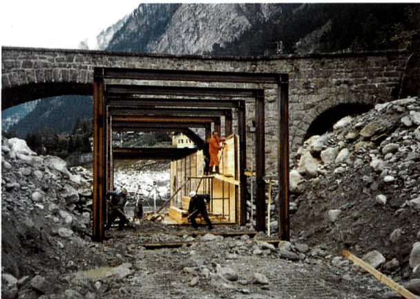
Bild 4. Erstellung Umleitkanal für Abflüsse von bis zu 150 m³/s.
