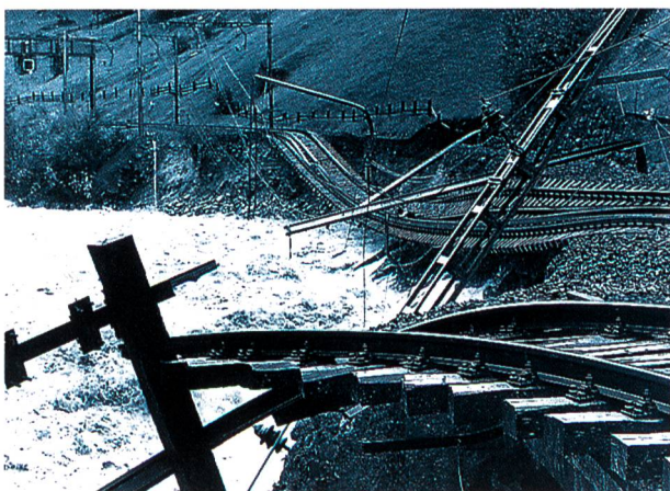
Bild 1. Zerstörtes SBB-Trasse (Comet Photo AG, Zürich).
