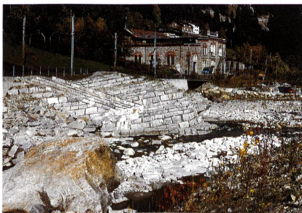
Bild 3. Hauptschutzelement A: Ansicht des Umlenksporns vom Oberwasser.
