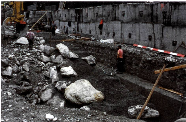
Bild 7. Hauptschutzelement C. 2fach verankerte Elementwand unterhalb der SBB-Stützmauer. Gewichtsmauer, etappenweise ausgeführt; Integrieren einer alten Bruchsteinmauer, welche beim Aushub zum Vorschein kam.
