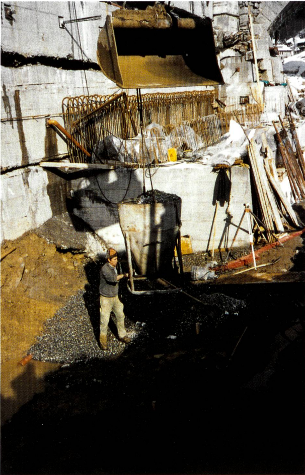
Bild 5. Entwässerung Fundamentbereich mit Sickerleitung, Sickerkies und Entwässerungsgraben.
