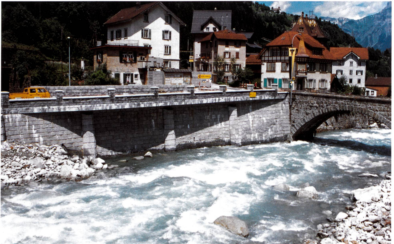
Hauptschutzelement C: Auskragung der Ufermauer beim Anschluss an die Wilerbrücke.
