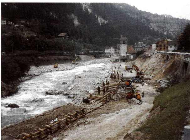
Bild 9. Krainerwand südlich der Kirche.
