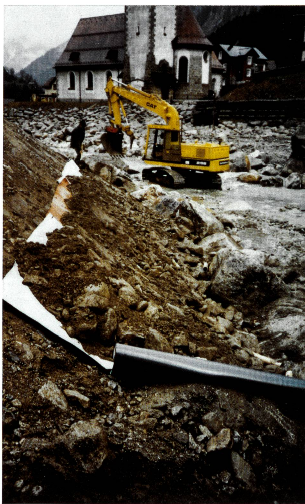
Bild 3. Abdichtung Schutzdamm mit Folie; Kolkschutz-Blöcke.
