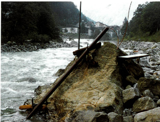
Bild 1. pH-Messstelle Nord, Messsonde in Schutzrohr.
