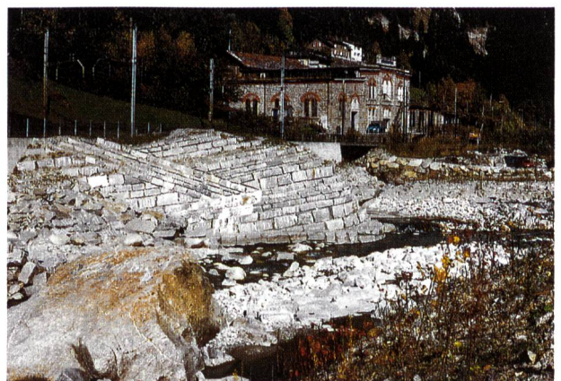
Bild 3. Hauptschutzelement A: Ansicht des Umlenksporns vom Oberwasser.
