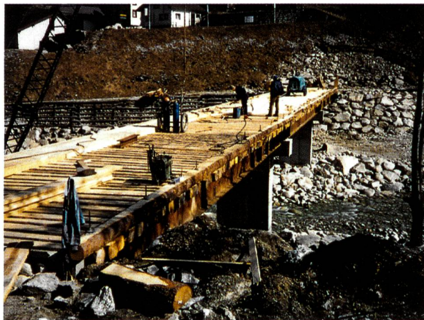
Bild 2. Erstellung der Baubrücke südlich Kirche.
