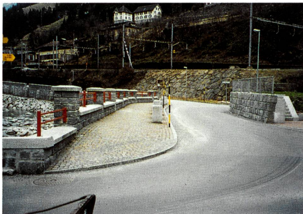
Bild 7. Auskragung flussaufwärts der Wilerbrücke.
