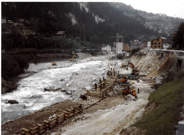
Bild 9. Krainerwand südlich der Kirche.
