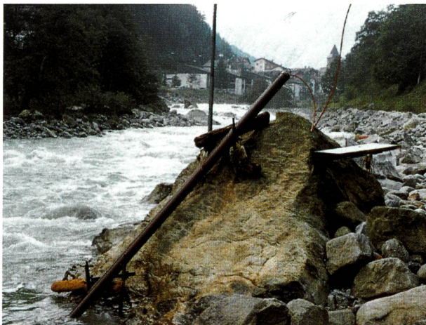
Bild 1. pH-Messstelle Nord, Messsonde in Schutzrohr.
