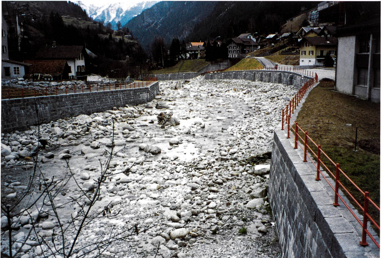
Bild 11. Ufermauer vor dem Kreisschulhaus bis zur Einmündung des Steintales.
