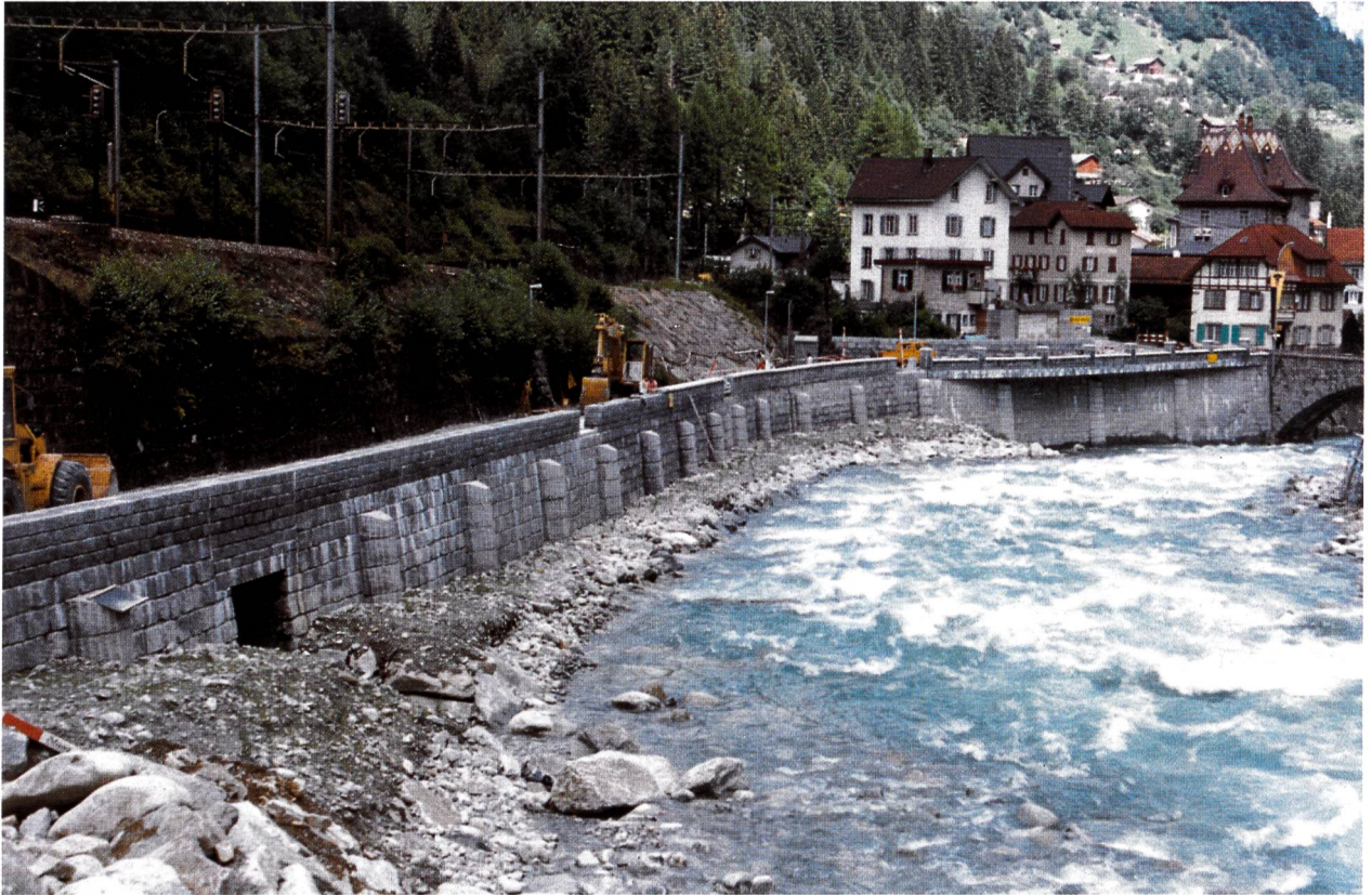
Bild 8. Hauptschutzelement C: Bruchsteinverkleidete Ufermauer oberhalb der Wilerbrücke.
