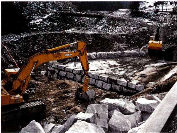
Bild 2. Hauptschutzelement A. Schichtweises Versetzen von Blocksteinen im Fundationsbereich des Umlenksporns. Armierung für einen diagonal halbierten Betonwürfel (Kantenlänge 2,75 m).
