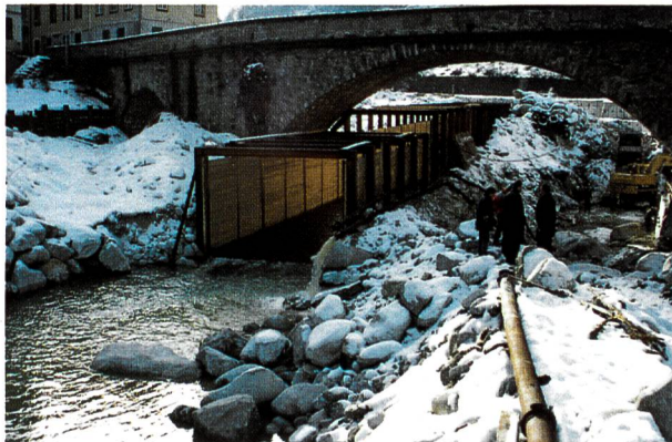
Bild 6. Hauptschutzelement C. Umleitkanal bei der Dorfbrücke.
