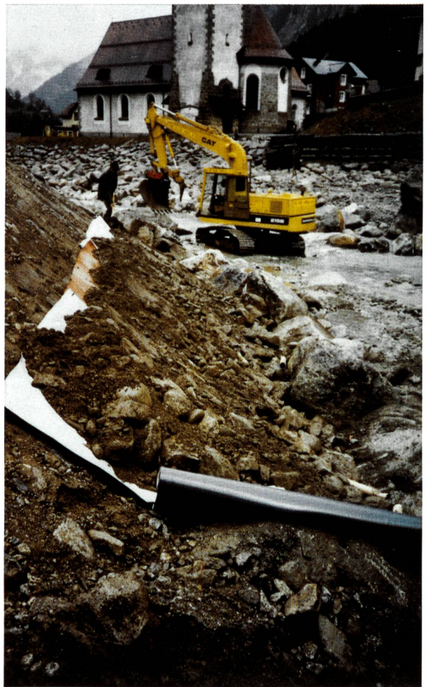
Bild 3. Abdichtung Schutzdamm mit Folie; Kolkschutz-Blöcke.
