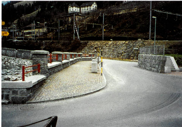
Bild 7. Auskrugung flussaufwärts der Wilerbrücke.
