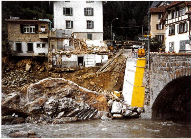
Bild 8. Unterfangung linkes Widerlager Wilerbrücke.
