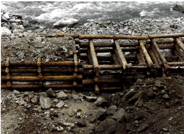
Bild 10. Krainerwand im Bau.
