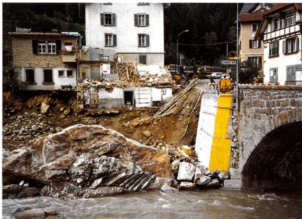
Bild 8. Unterfangung linkes Widerlager Wilerbrücke.
