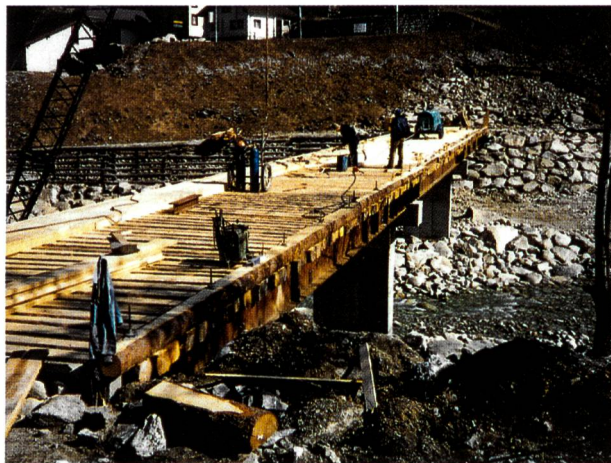
Bild 2. Erstellung der Baubrücke südlich Kirche.
