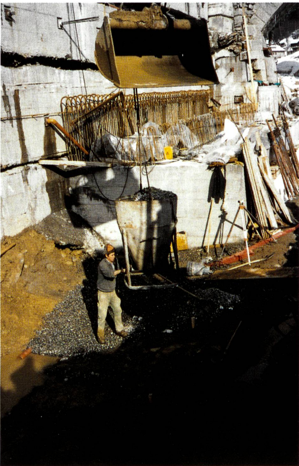
Bild 5. Entwässerung Fundamentbereich mit Sickerleitung, Sickerkies und Entwässerungsgraben.
