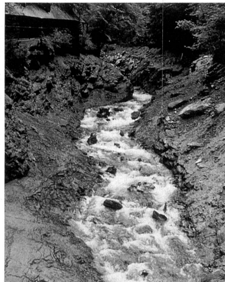
Bild 3. Das während der Spülung entleerte Staubecken.
