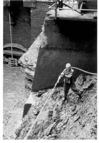
Bild 2. Der seitliche Schlamm wird weggespritzt.
