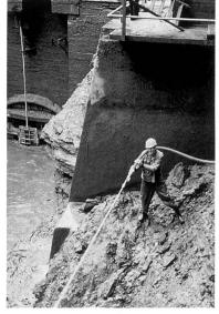
Bild 2. Der seitliche Schlamm wird weggespritzt.
