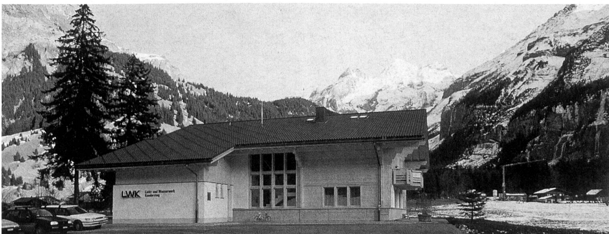
Bild 2. Die neue Kraftwerkzentrale Dorf ist im Untergeschoss des Chalets untergebracht.
