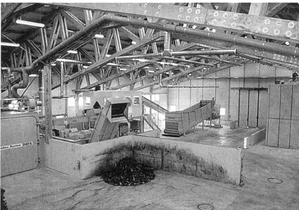
Bild 2. Der Bioabfall wird per Radlader seitlich in den Flachbunker (Bildmitte rechts) gegeben, auf der Vibrorinne vereinzelt, per Magnetabscheider von Stahl- und Eisenschrott und in der Sortierkabine von Störstoffen befreit. Es folgt die Zugabe von geshreddertem Grünschnitt. Das Rohmaterial (im Vordergrund) wird mit dem Radlader in die Rotteboxen gefüllt.
