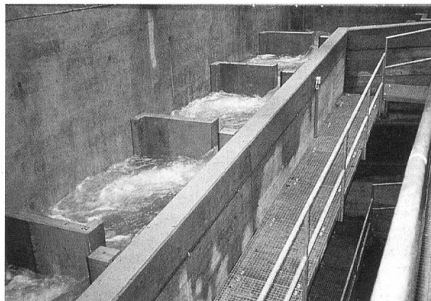
Bild 3. Im treppenhausartigen Schachtbauwerk des Fischpasses Aarberg.
