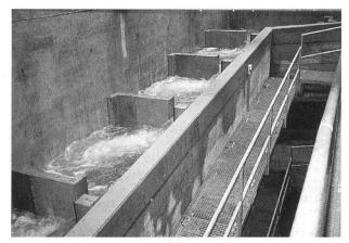
Bild 3. Im treppenhausartigen Schachtbauwerk des Fischpasses
