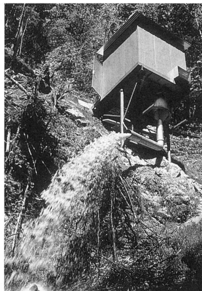
Figure 6, à droite. La Douve 2, vue de sous son débit d'eau de restitution, après returbinaage des eaux turbinées par sa grande sœur, 83 mètres en amont. «Par chance, il n'y a pas de poissons dans la Douve (c'est aussi le nom de la rivière!), parce que sinon, l'obligation de leur construire une échelle a souvent pour conséquence de ne plus rendre l'opération très rentable», reconnaît Roger Galé avec lucidité. La mise en place de la mini-centrale sur son chassis par un hélicoptère n'a duré que 28 minutes.
