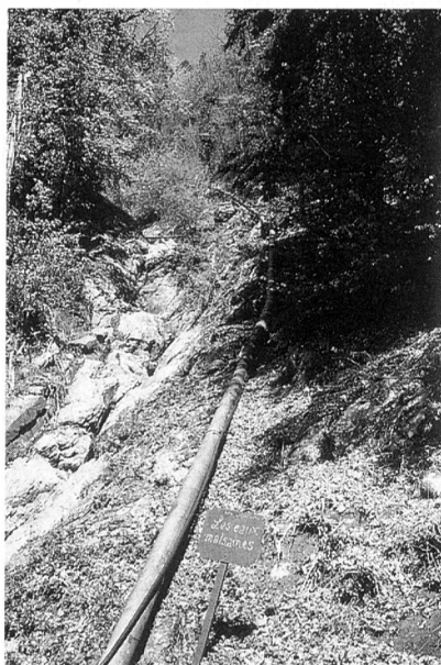
Figure 1, à gauche. Vue sur la conduite forcée en direction du bassin de mise en charge alimenté par la STEP de Leysin, située à 550 mètres en amont. Pour la petite histoire, la pancarte sur la droite indiquant «eaux malsaines» date d'avant la création de la Douve 1, pour prévenir d'éventuels cyclistes assoiffés que cette eau, en apparence claire parce qu'épurée, n'était en fait pas potable...
