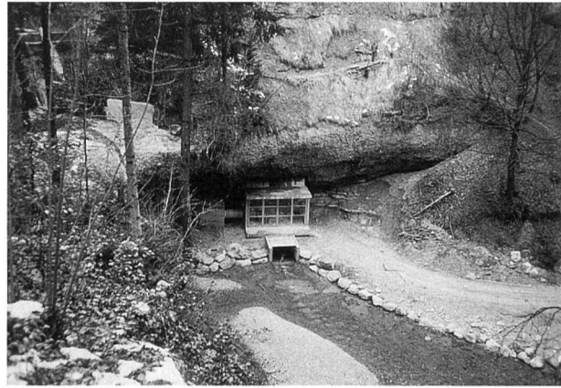
Bild 5. Das Maschinenhaus ist zwecks Besichtigung grosszügig dimensioniert und mit einer Glasfront versehen. Unter die Felsnase des Wasserfalles plaziert, ist es vor Steinschlag geschützt und gut in die Landschaft integriert. (Foto Iteco Januar 1996)
