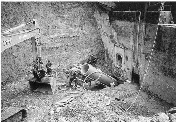
Bild 4. Das Bohren und Verlegen der Druckleitung war technisch anspruchsvoll und stets von Überflutungsrisiko begleitet. Die elegante Lösung ist kostengünstig, energieeffizient und schont das Landschaftsbild. (Foto Iteco, September 1995)
