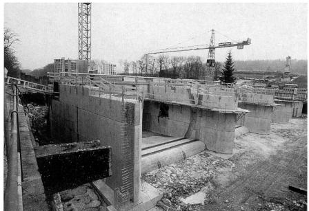
Bild 9, links. Turbineneinlauf. Übergang vom Quadratquerschnitt (12×12 m) zum Kreisquerschnitt des Leitapparates (Durchmesser 9,25 m), eingeschalt der 3 m hohe Generatorschachtsockel.
