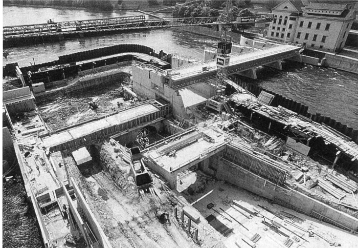
Bild 6, rechts. Baugrube Maschinenhaus. Infolge heikler Untergrundverhältnisse musste diese etappiert werden. Die Aare ist während dieser Bauphase durch das neuerstellte Wehr umgeleitet, die Schützen sind noch nicht eingebaut.
