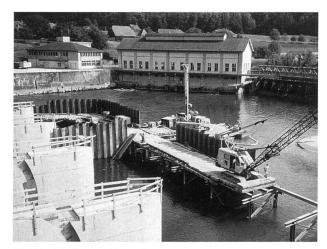
Bild 11. Arbeiten am Fangedamm.
