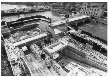
Bild 6, rechts. Baugrube Maschinenhaus. Infolge heikler Untergrundverhältnisse musste diese etappiert werden. Die Aare ist während dieser Bauphase durch das neuerstellte Wehr umgeleitet, die Schützen sind noch nicht eingebaut.
