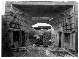
Bild 7. Saugrohr-Austrittsquerschnitt (13,6×8,5 m).
