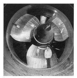
Bild 5, links. Turbine; Laufraddurchmesser 5,6 m, 220 m³/s Ausbauwassermenge,12 MW.
