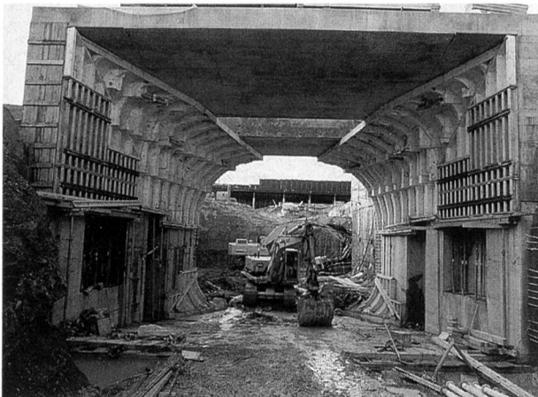
Bild 7. Saugrohr-Austrittsquerschnitt (13,6×8,5 m).
