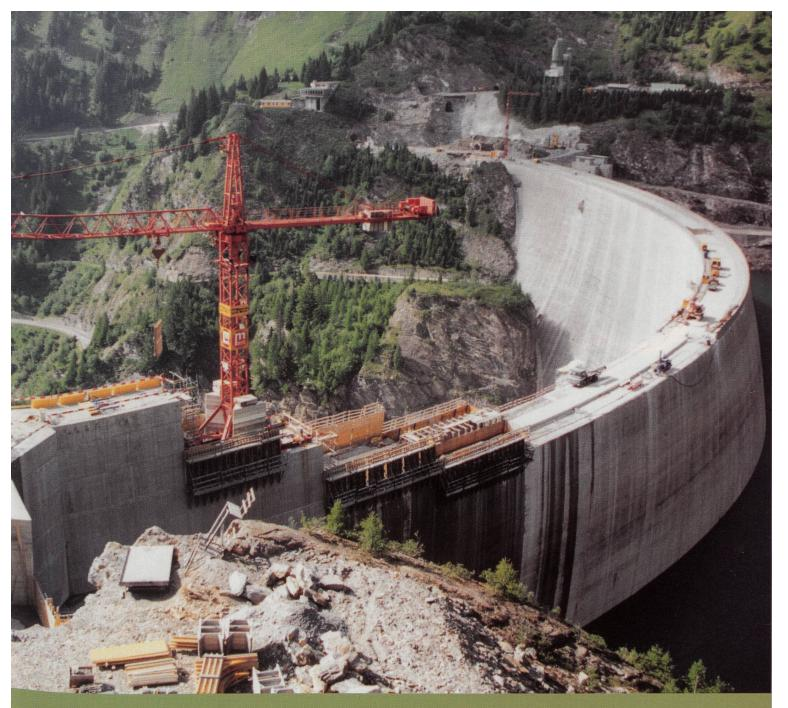
Pour la surélévation de 17 m de la digue de Luzzone de la Officine idroelettriche di Blenio SA au Tessin un volume de béton de 70 000 m³ sera nécessaire. Ce sont 5% du volume total de la digue qui est 208 m de haut. A l'occasion de la 85° Assemblée générale de l'Association suisse pour l'aménagement des eaux les jeudi (Lugano) et vendredi, 10 et 11 octobre 1996 une excursion mène au chantier de la surélévation Luzzone.
