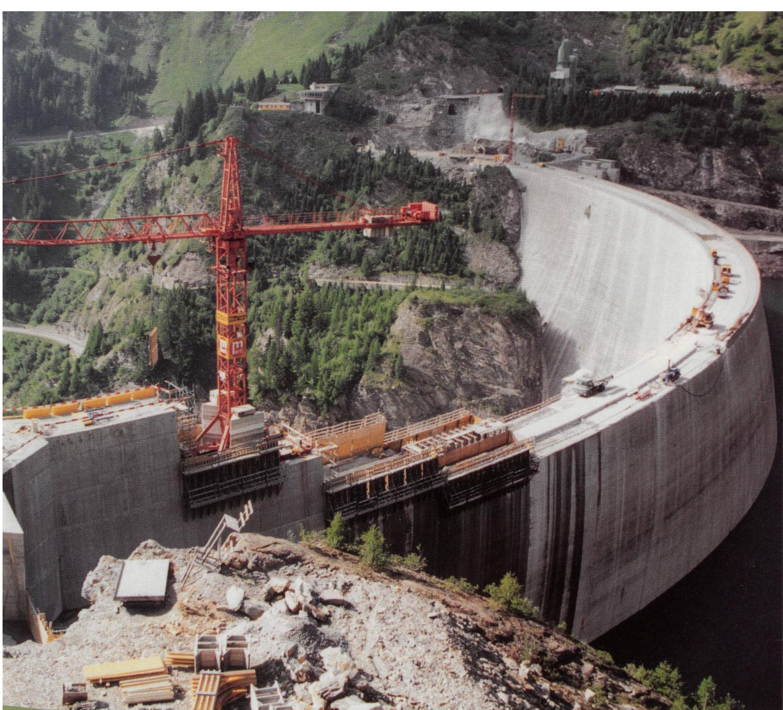
Pour la surélévation de 17 m de la digue de Luzzzone de la Officine idroeletriche di Blenio SA au Tessin un volume de béton de 70 000 m<sup>3</sup> sera nécessaire. Ce sont 5 % du volume total de la digue qui est 208 m de haut. A l'occasion de la 85<sup>e</sup> Assemblée générale de l'Association suisse pour l'aménagement des eaux les jeudi (Lugano) et vendredi, 10 et 11 octobre 1996 une excursion mène au chantier de la surélévation Luzzzone.
