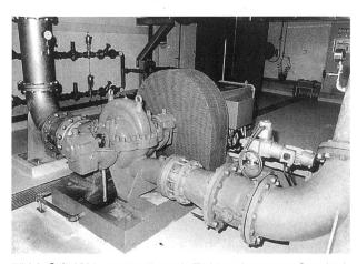
Bild 1. Seit 1993 erzeugt diese als Turbine eingesetzte Standard-Pumpe (links) mit dem direkt gekoppelten Generator in Nyon VD jährlich rund 700 000 kWh Strom aus Abwasser.
