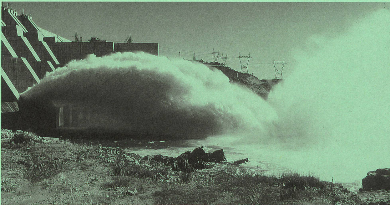
Hochwasserentlastung an der Stauanlage Jaguara in Brasilien.
