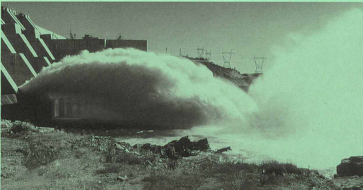
Hochwasserentlastung an der Stauanlage Jaguara in Brasilien.
