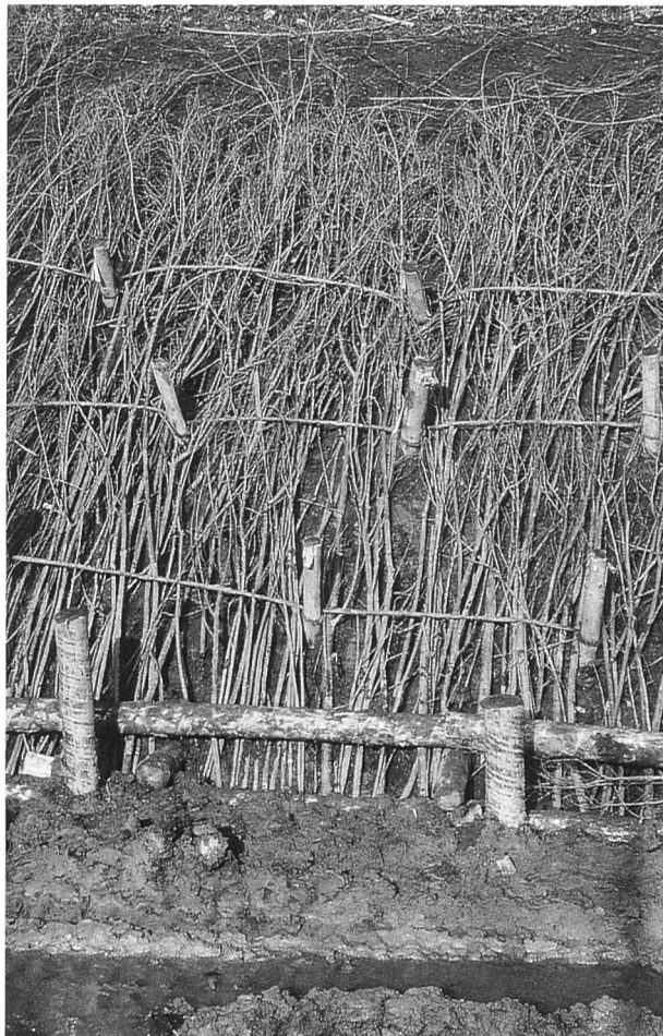
Bild 10. Ingenieurbilogische Ufersicherung mit einer Spreitlage vor dem Abdecken mit Erde. Der Böschungsfuss wird mit einem einfachen Holzkasten gesichert, der teilweise eingegraben ist. (Alsbach Wien, März 1995/ Bild: VAW, M. Oplatka)
