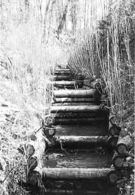
Bild 3, links. Ingenieurbiologische Bautechniken werden im Erd- und Wasserbau zur Lösung von Erosions- und Instabilitätsproblemen verwendet. (Worble BE, Mai 94/ Bild: VAW, M. Oplatka).
