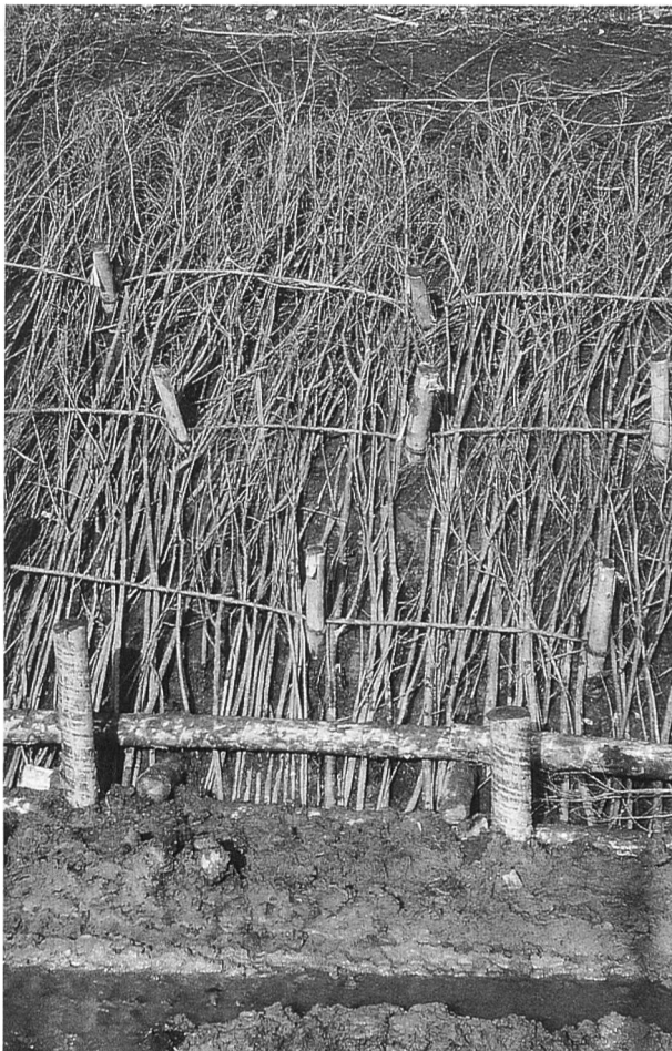
Bild 10. Ingenieurbio-logische Ufersicherung mit einer Spreitlage vor dem Abdecken mit Erde. Der Böschungsfuss wird mit einem einfachen Holzkasten gesichert, der teilweise eingegraben ist. (Alsbach Wien, März 1995/ Bild: VAW, M. Oplatka)
