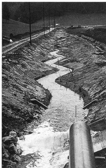
Bild 6, Mitte. Das Verständnis von Systemzusammenhängen ist nötig, damit Verbauungen langfristig erfolgreich wirken. Fehlendes Prozessverständnis führte zur Rutschung unterhalb einer Filterschicht. (Meliorationsstrasse Tschierschen GR, 1987/Bild WSL, W. Gerber , No. 87-12/36).
