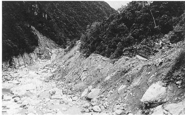
Bild 16. Abgerutschte Zufahrtsstrasse am Gegenhang des Maschinenhauses Mollino. Der ganze Hang ist destabilisiert.
