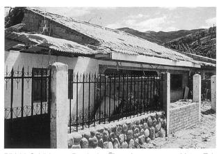
Bild 14. Schäden am Rande des Überschwemmungsgebietes. Teile von Paute zeigten nur Überschwemmungsschäden. Die Höhe der Wasserstände lässt sich am Sand auf den Hausdächern abschätzen.
