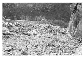
Bild 7. Ablenkdamm beim Kegelhals, Kote 830 m bis 810 m. Das alte Gerinne auf der rechten Kegelseite und die Strecke beim Schluchtausgang wurden ausgebaggert. (Foto: *G. Valenti*, Cadenazzo, April 1993)
