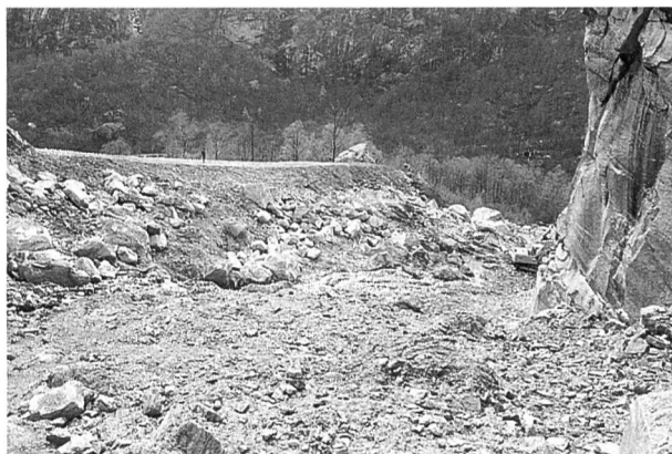
Bild 7. Ablenkdammbau beim Kegelhals, Kote 830 m bis 810 m. Das alte Gerinne auf der rechten Kegelseite und die Strecke beim Schluchtausgang wurden ausgebaggert. (Foto: G. Valenti, Cadenazzo, April 1993)
